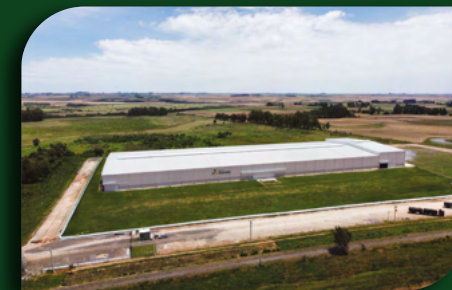
Centro de Tratamento, Armazenamento e Distribuição Tupanciretã/RS
